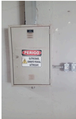
Quadro de Comando de Iluminação
