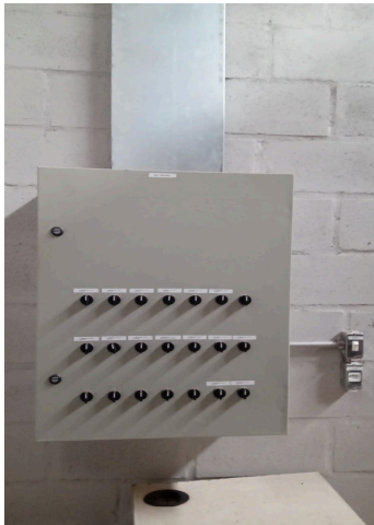
Quadro de Comando de Iluminação
