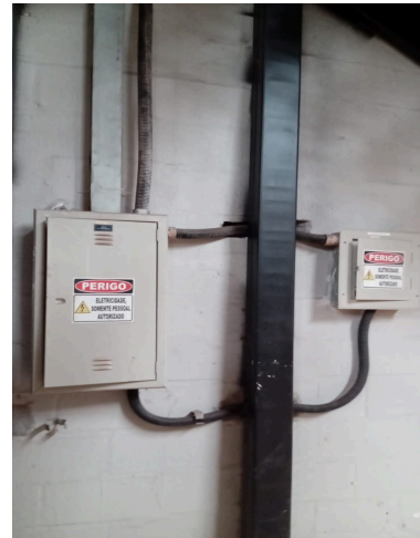
Quadro Principal de Disjuntores Elétricos
