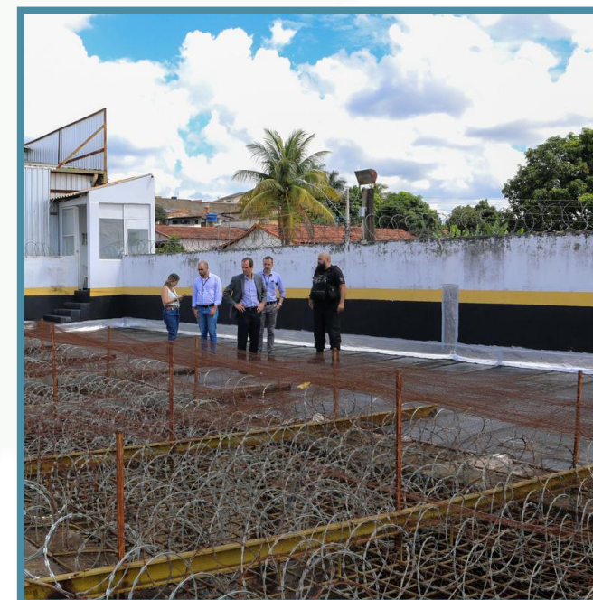
TELHADO DO PRESÍDIO
