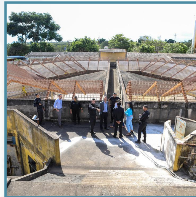
TELHADO DO PRESÍDIO
